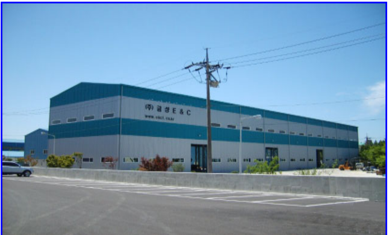
제 2공장 전경
