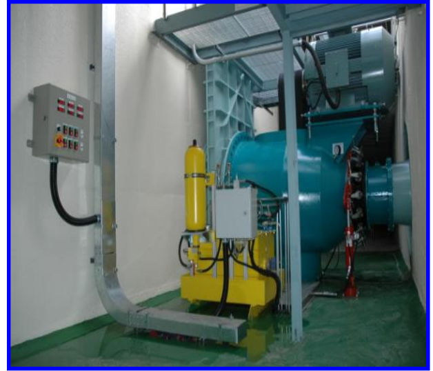
판교소수력 수차발전기 설치
