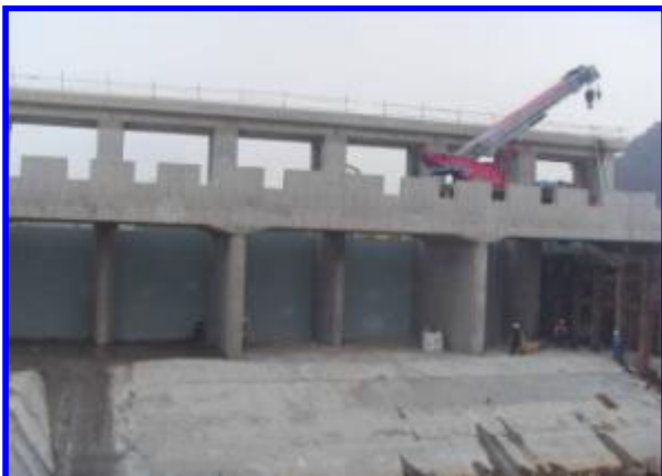
당진화력 방조제 수문 제작 설치
