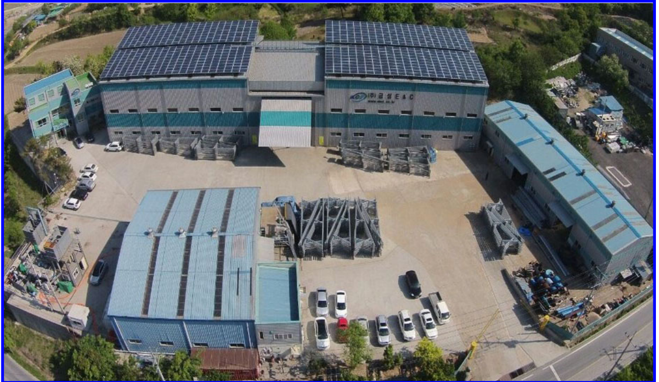
제 1공장 전경
