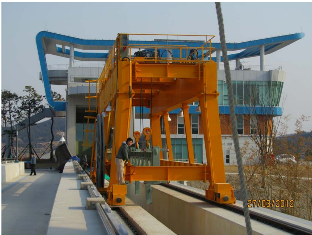
스톱록 설치용 겐츄리크레인 모습.
