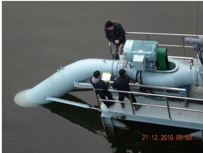
Site : JOOAM MHP Head : 6.8m Flow : 0.95cms Output : 50kW x 1unit Speed : 600 rpm
