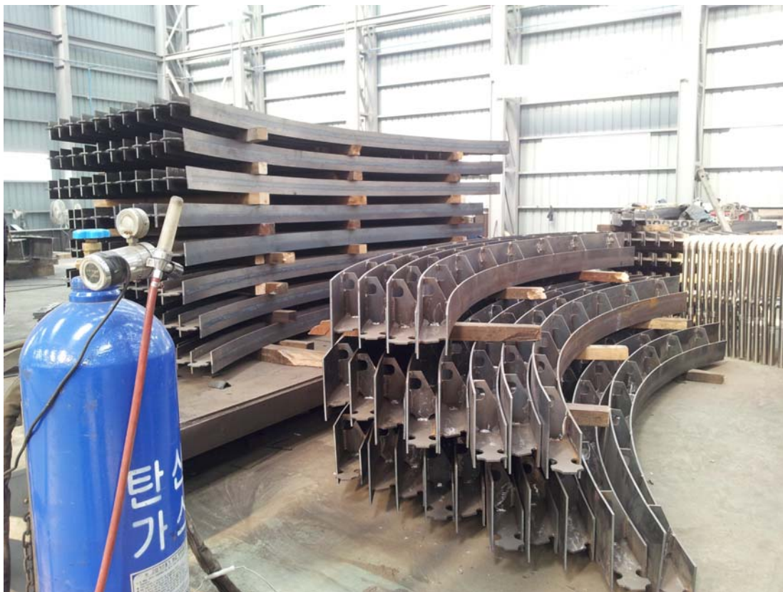
△ 문비 골조용 H-Beam 제작 상태
